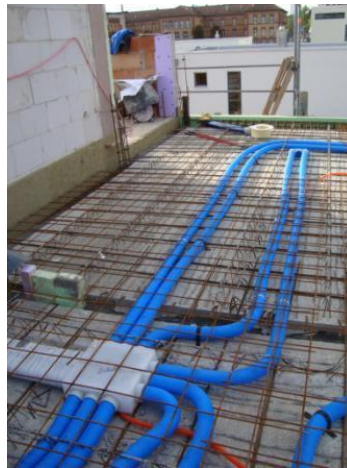
Şekil 12. Beton içi kanal uygulaması
